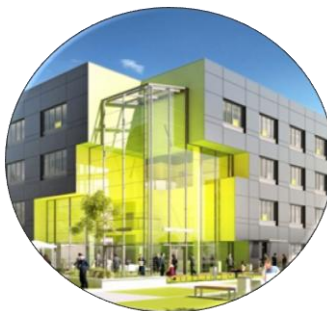
TECHNOPARK POMERANIA BUDYNEK F2, F3, F4
